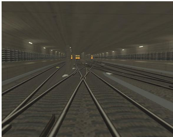
Hier nun kann man einen Streckentunnel mit seinen typischen Details erkennen. Zunächst sind da die beiden Streckengleise mit ihren von unten bestrichenen Stromschielen. Außerdem ist das Tunnellicht eingeschaltet, wie es allerdings momentan in meiner Simulation überall ist.
